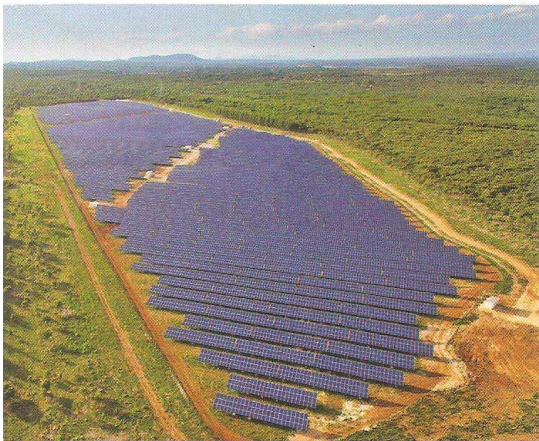
Les centrales de Belvézet (30) ont l'intérêt de rouvrir le milieu que fermaient les garrigues.
