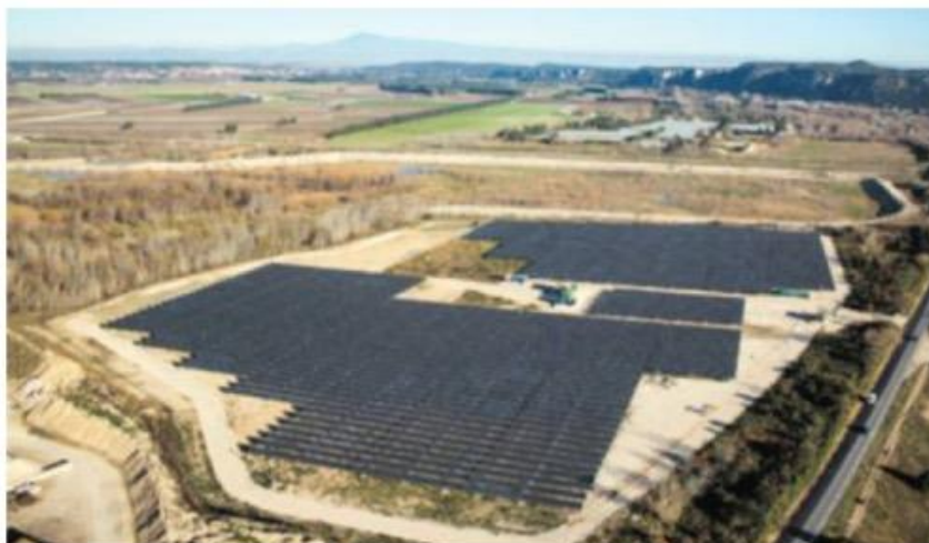
Les 10 740 panneaux de SunPower de la centrale sont capables de produire à leur pic quelque 6,2 gigawattheures (GWh) par an. GÉNÉRALE DU SOLAIRE
